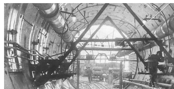
Строительство первого технологического тоннеля на Шесхарисе, 1963 год
