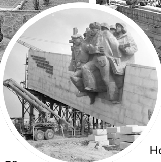
Строительство мемориала «Малая земля», 1981 год
