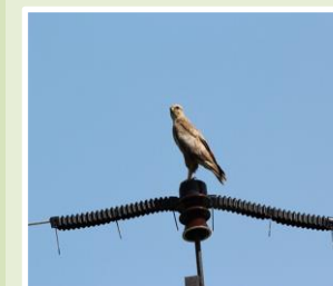
Установка птицезащитных устройств
